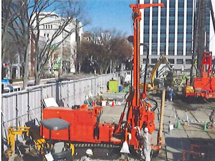
地中熱探熱孔掘削
