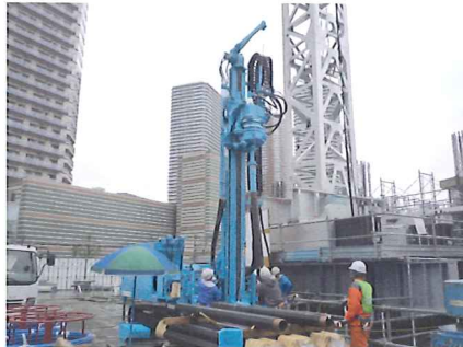
地中熱探熱孔掘削
